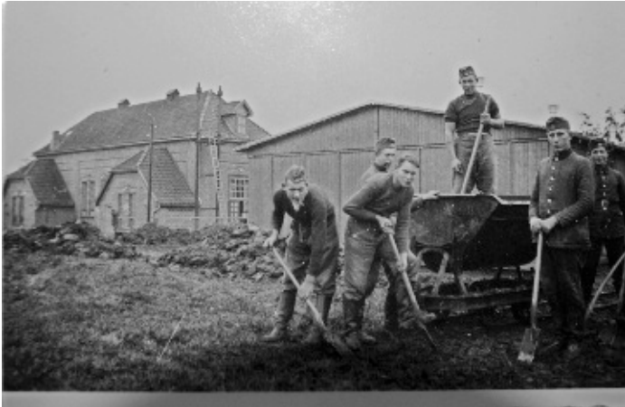
Bei Drainagearbeiten. Im Hintergrund das Schöpfwerk (Aus dem Nachlass von Herrn Eckert, Otterndorf. Im Besitz des Kreisarchivs)
