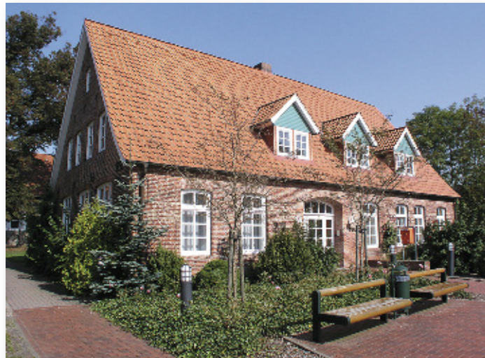
Alte Hauptschule heute.
